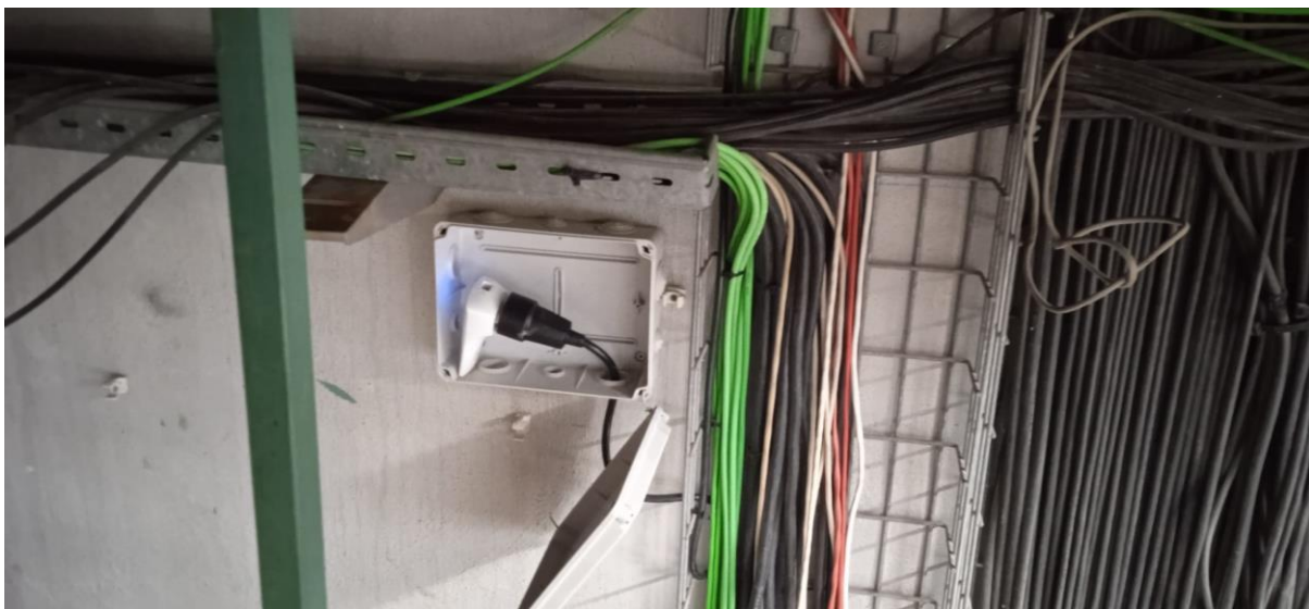
Figura 16: Caja de pared donde está instalado el extensor WiFi
