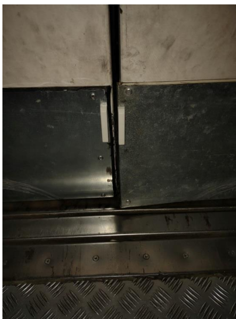
Figura 20: Contacto magnético para detección de apertura de puerta
